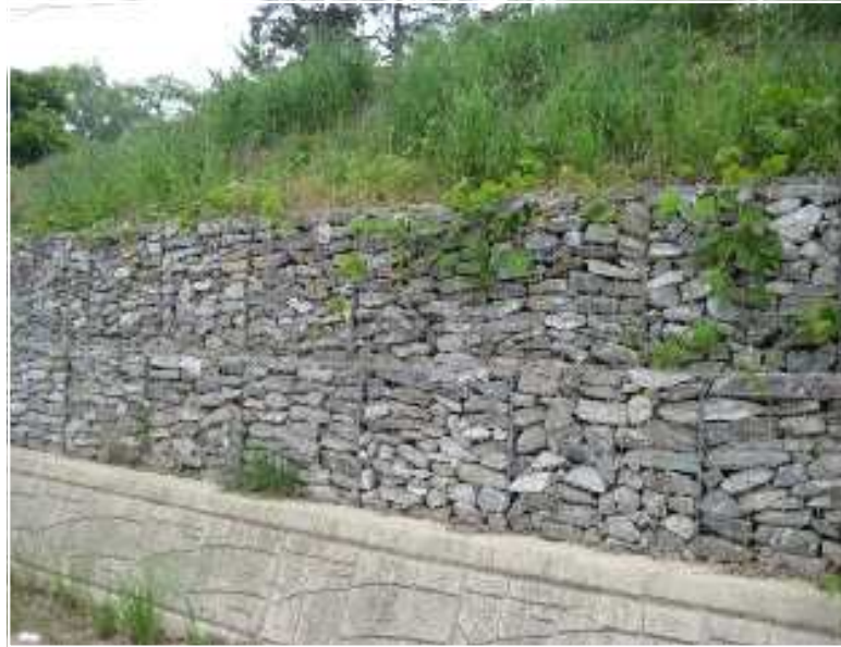
[사진 2-7] 돌망태 옹벽
